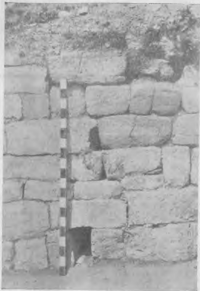
Рис. 6. Деталь оборонительной стены с водостокom.
