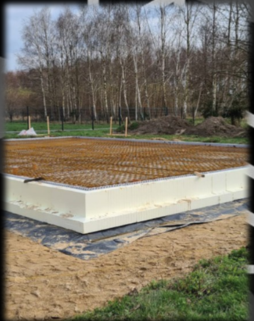
Укладка фундаментной плиты IZODOM
