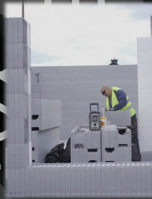
Строительство стен IZODOM
