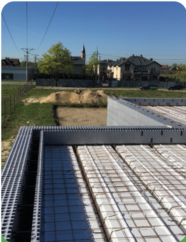
Укладка перекрытия IZODOM
