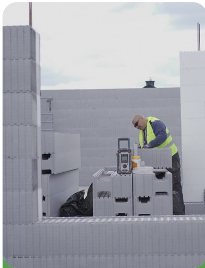
Строительство стен IZODOM
