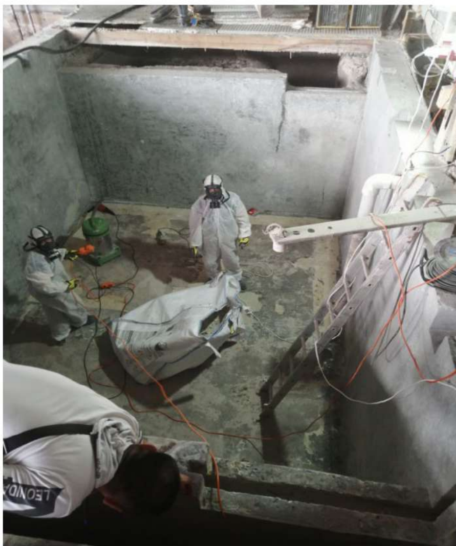
Рис.28 Работы по антикоррозионной защите на объекте ООО «Сода Хлорат» бассейн солерастворения, зачистка поверхности
