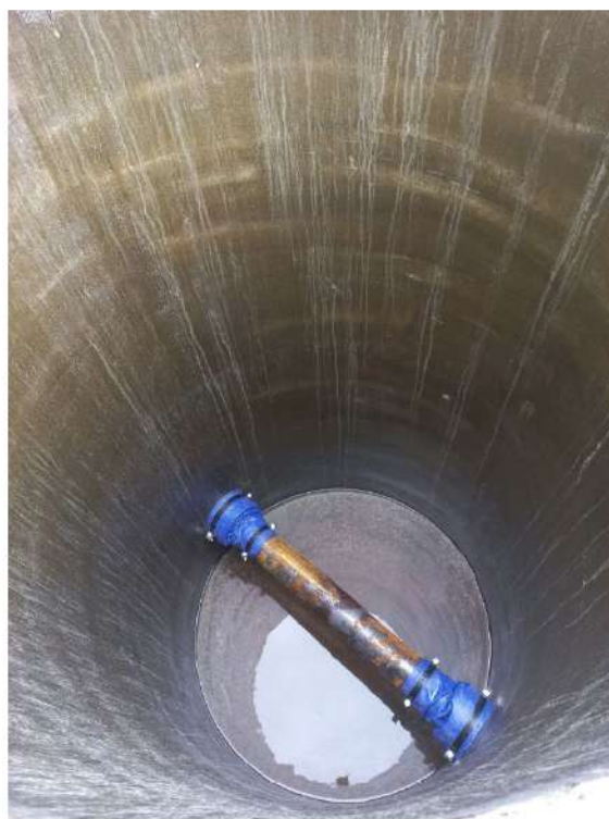
Рис. 7 соединение трубы внутри колодца
