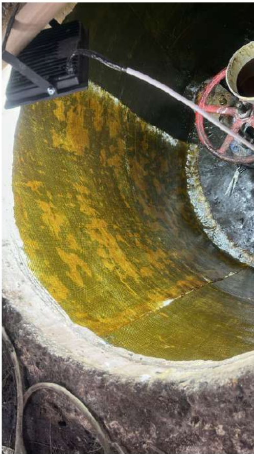
Рис. 1. Ремонт колодца на сетях газораспределения
