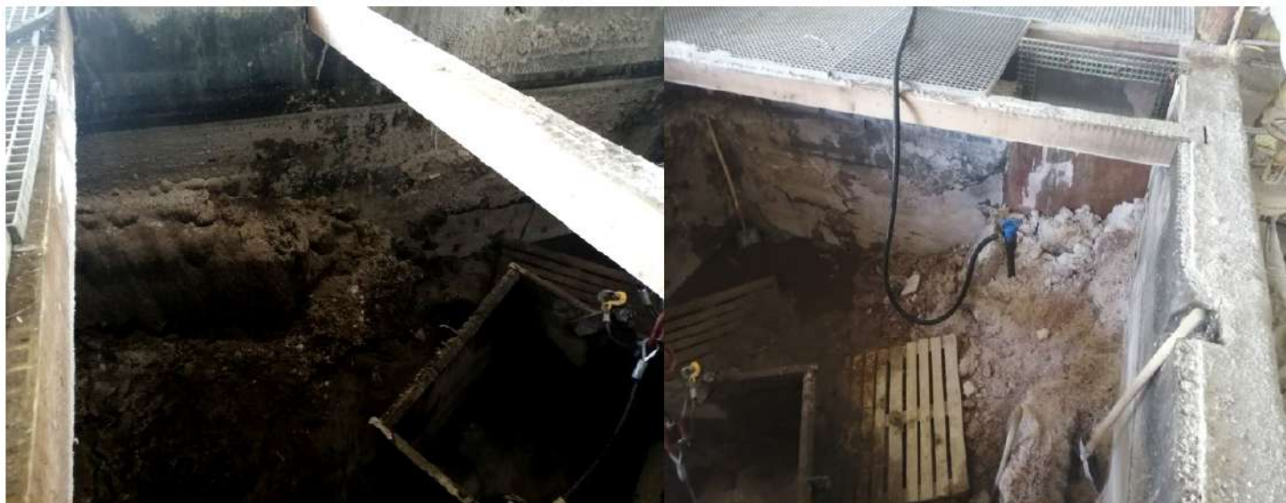
Рис.26,27 Работы по антикоррозионной защите на объекте ООО «Сода Хлорат» бассейн солерастворения, состояние до ремонта
