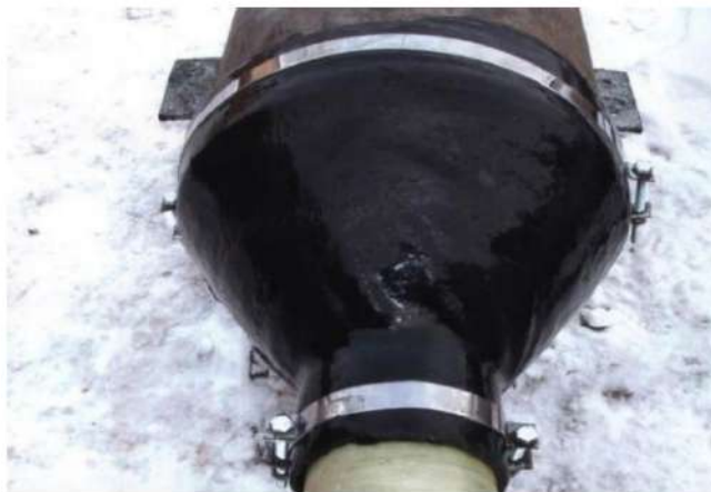
Рис.8,9 Технология с применением гидроизоляционной манжеты «ДеКом»
