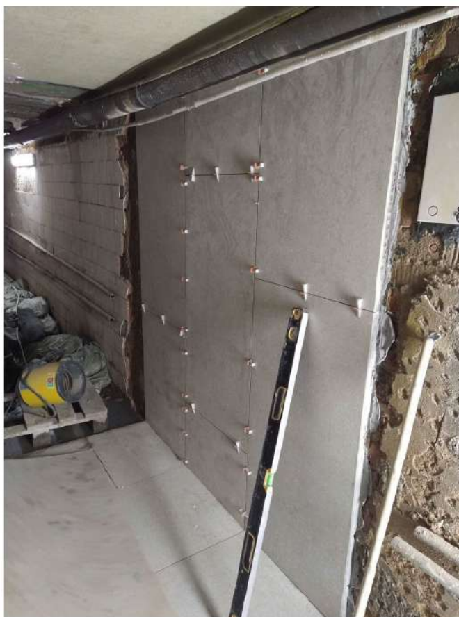
Рис.16 Гидроизоляционные работы на объекте "Больница № 67 им. Л.А.Ворохובה, по адресу г. Москва, ул. Саляма Адиля 2/44" укладка керамогранитной плитки
