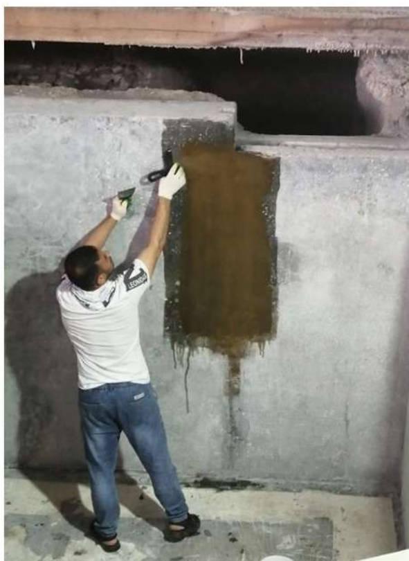
Рис.30 Работы по антикоррозионной защите на объекте ООО «Сода Хлорат» бассейн солерастворения, нанесение материала «ДеКом»
