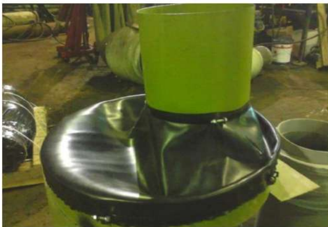
Рис.8,9 Технология с применением гидроизоляционной манжеты «ДеКом»
