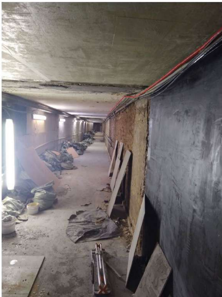
Рис. 15 Гидроизоляционные работы на объекте "Больница № 67 им. Л.А.Ворохובה, по адресу г. Москва, ул. Саляма Адиля 2/44" нанесение защитного состава
