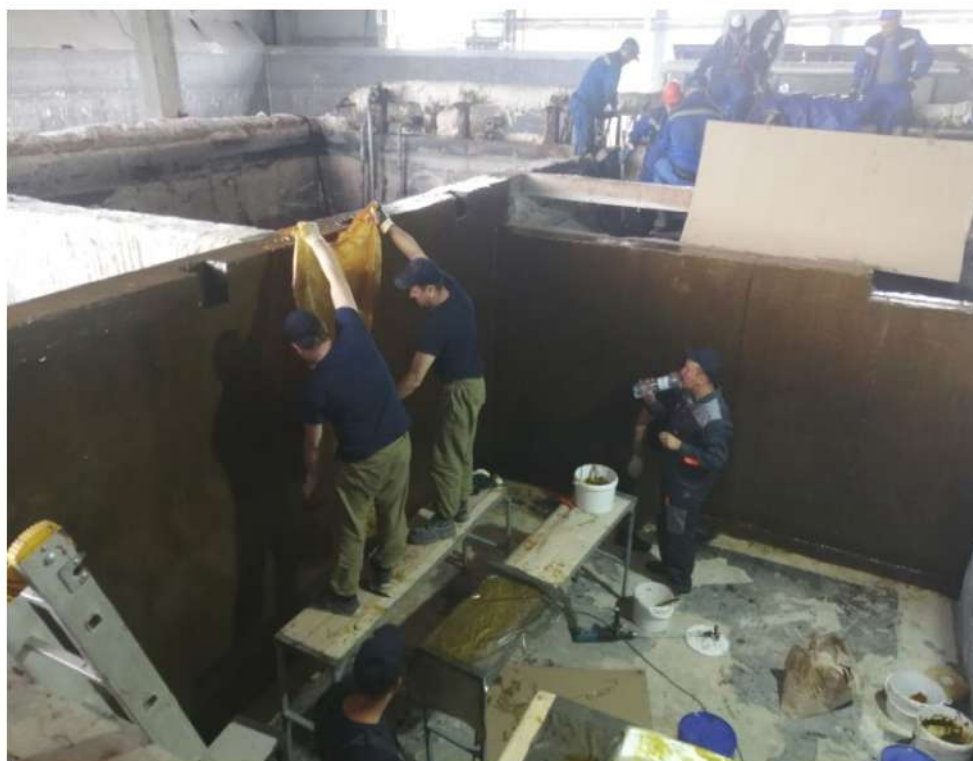
Рис.34,35 Работы по антикоррозионной защите на объекте ООО «Сода Хлорат» бассейн солерастворения, нанесение материала «ДеКом»
