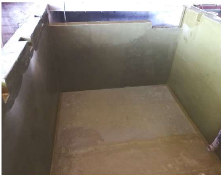
Рис. 37,38 Работы по антикоррозионной защите на объекте ООО «Сода Хлорат» бассейн солерастворения, состояние после ремонта
