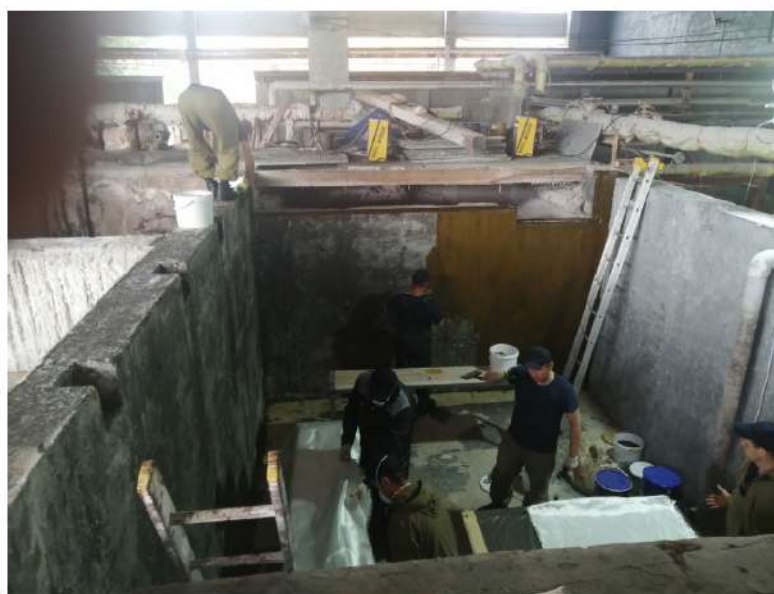
Рис. 32,33 Работы по антикоррозионной защите на объекте ООО «Сода Хлорат» бассейн солерастворения, нанесение материала «ДеКом»
