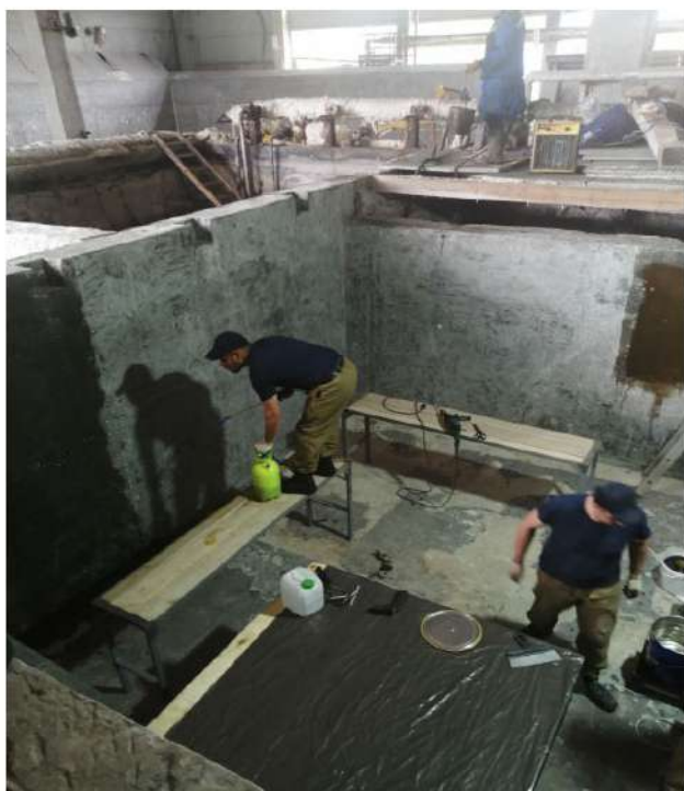
Рис. 32,33 Работы по антикоррозионной защите на объекте ООО «Сода Хлорат» бассейн солерастворения, нанесение материала «ДеКом»
