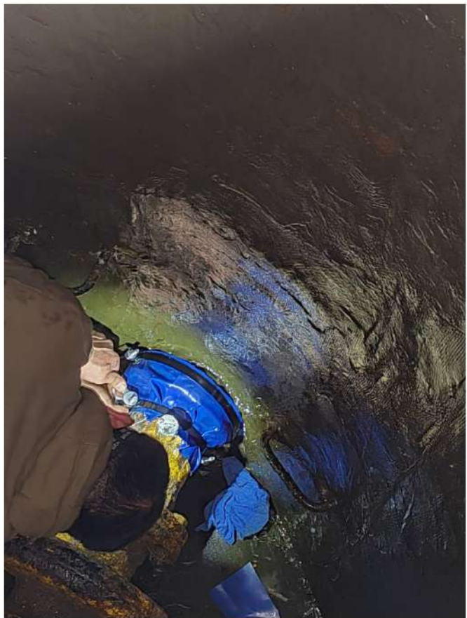
Рис. 2 Ремонт колодца на сетях газораспределения
