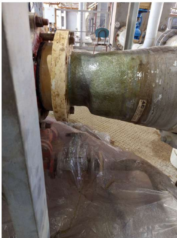
Рис. 37,38 Работы по антикоррозионной защите на объекте ООО «Сода Хлорат» бассейн солерастворения, состояние после ремонта
