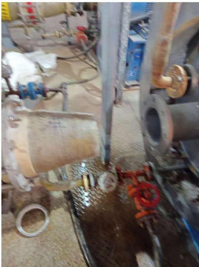
Рис.39,40 Аварийный ремонт перехода рассолопровода на ООО «Сода Хлорат», выполнен за три часа с переключением задвижки, без остановки основного производства
