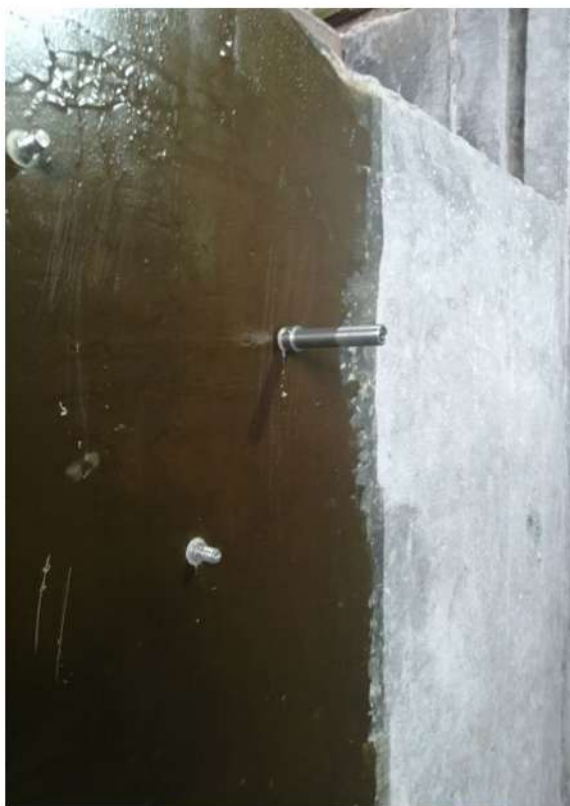
Рис.31 Работы по антикоррозионной защите на объекте ООО «Сода Хлорат» бассейн солерастворения, проверка адгезии материала «ДеКом» к бетону
