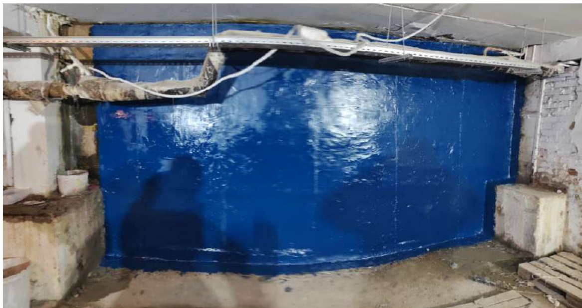
Ремонт аварийного подвала на объекте Городская клиническая больница имени С.С. Юдина по адресу г. Москва, Коломенский проезд, 4, состояние после ремонта
