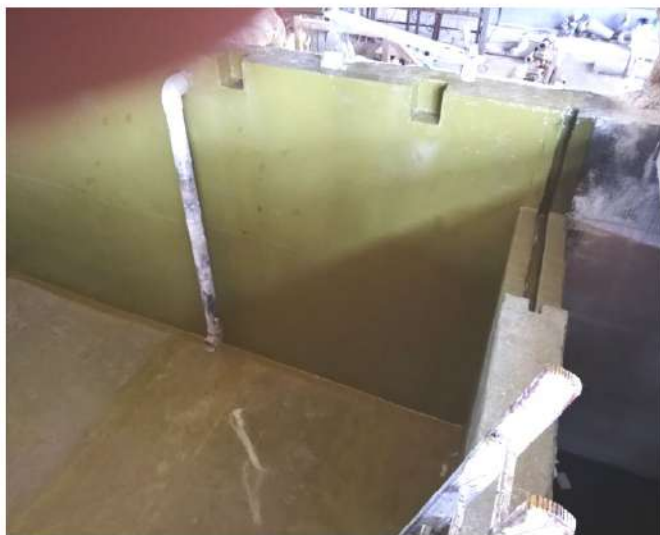
Рис. 37,38 Работы по антикоррозионной защите на объекте ООО «Сода Хлорат» бассейн солерастворения, состояние после ремонта
