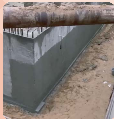
3023 Изолатекс: гидроизоляция наружных стен подземного паркинга ЖК Фотограф, Санкт-Петербург
