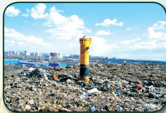
От газосборных скважин прокладываются газосборные и газотранспортные трубопроводы, которые соединяют скважины с газосборными станциями. На полигоне ТКО «Кучино» было построено 8 газосбор-
