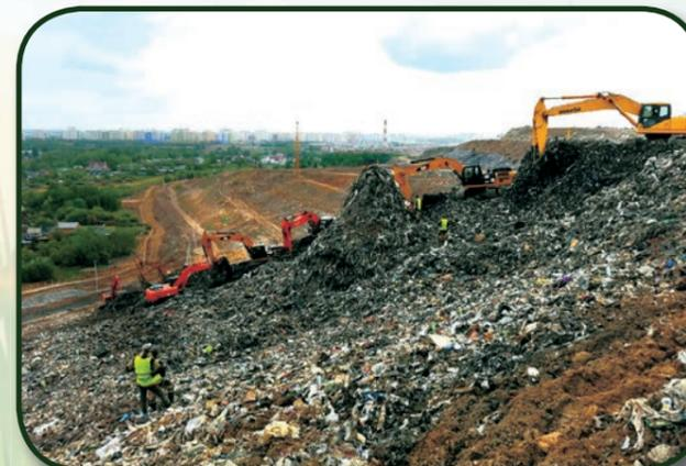
системы равномерного сбора свалочного газа было принято решение срезать крутые склоны полигона и переместить свалочный грунт на плато. В результате получается пологий склон с совокупным углом откоса 21,8 градуса. Всего было перемещено свыше 4 млн м³ свалочного грунта.
