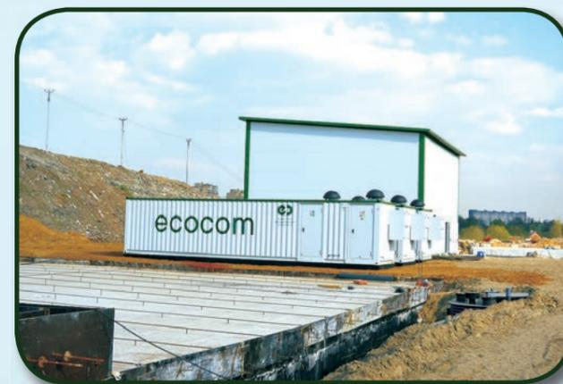
фильтрат откачивается и отводится в резервуар для сбора фильтрата и далее на установку обратного осмоса для очистки фильтрата. Чтобы предотвратить утечки в атмосферу сероводорода и летучих органических соединений, которые образуются от испарения фильтрата внутри резервуара, вредные газы отводятся на многослойный скруббер, который позволяет их обезвредить.
