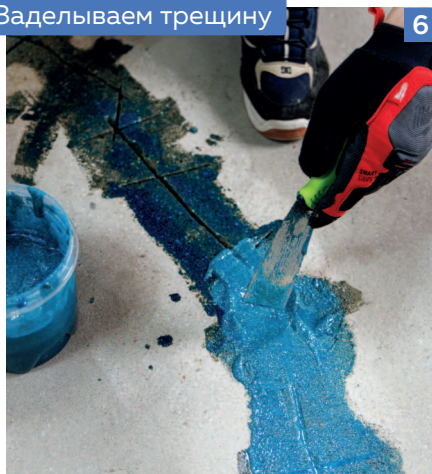
Заделываем трещину
