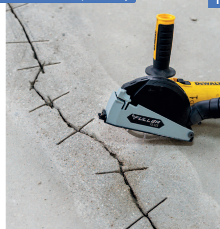
Расширяем трещину
