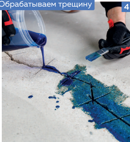
Обрабатываем трещину
