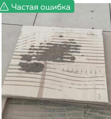
Используйте правильный шпатель и пригружайте приклеиваемое покрытие после укладки на клей!
