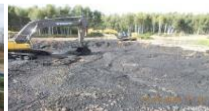
извлечение осадков на ВК
