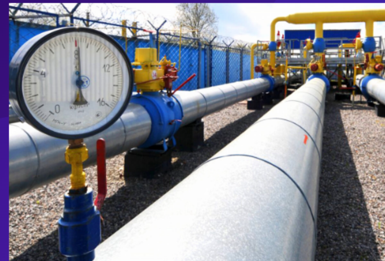
Проектирование и строительство газоподающих сетей
