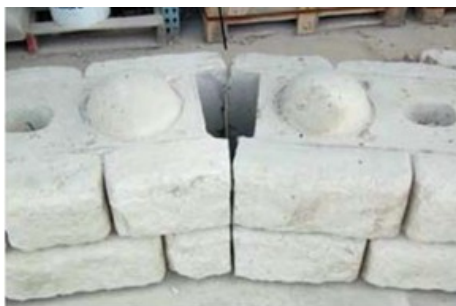
Рисунок 8.25- Подрезка блоков подгруппы «Р»
