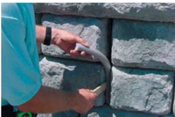
Рисунок 8.26- Пример заполнения швов между блоками
