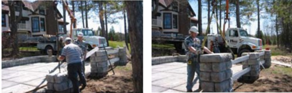
Рисунок 8.30- Пример устройства забора между колоннами
