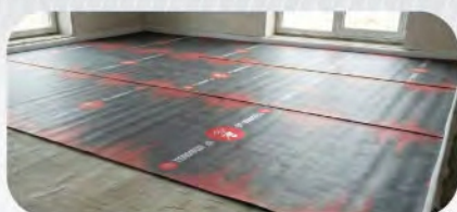
МАТЕРИАЛ УКЛАДЫВАЮТ НА ПОЛ
