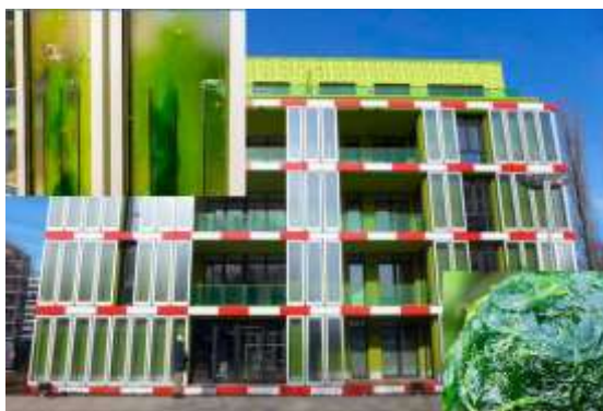
Рисунок 3. Новые технологии в строительстве - альтернативная энергия водорослей
