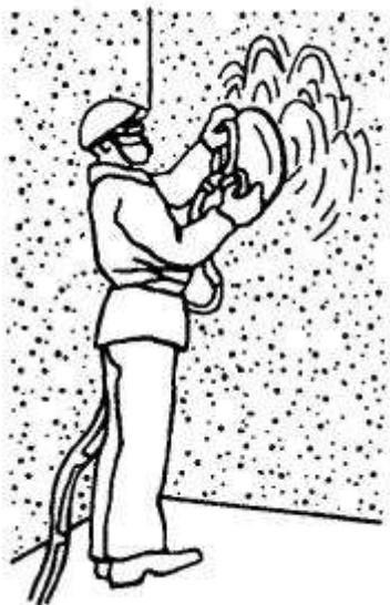
Рисунок 8 – Механизированная затирка поверхности
