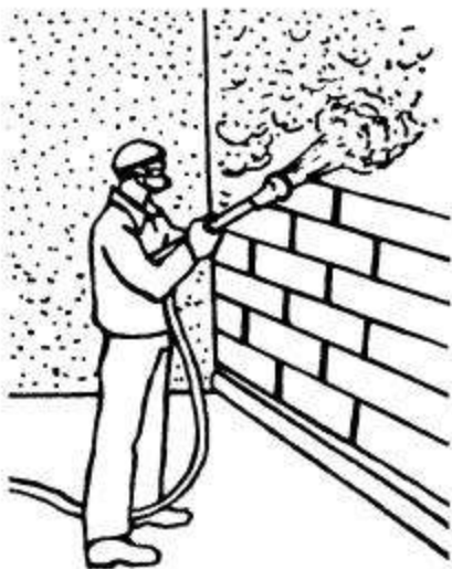
Рисунок 5 - Последовательное нанесение слоев обрызга, грунта
