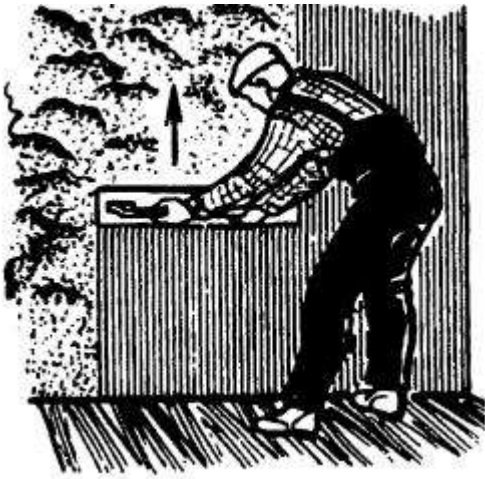
Рисунок 6 - Разравнивание раствора полутерком
