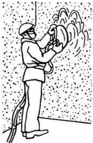
Рисунок 8 – Механизированная затирка поверхности
