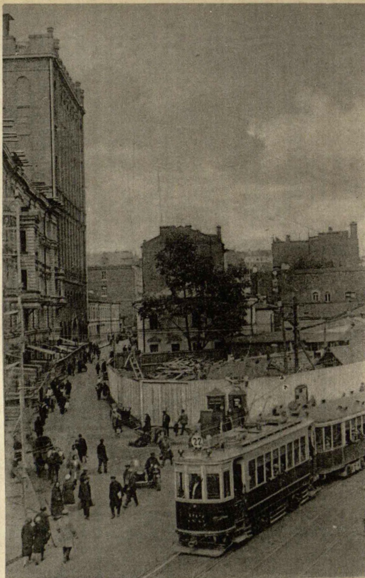
НА МЕСТЕ ЦЕРКВИ СТРОИТСЯ МЕТРОПОЛИТЕН.
