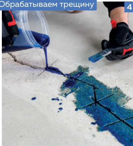
Обрабатываем трещину
