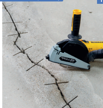
Расширяем трещину
