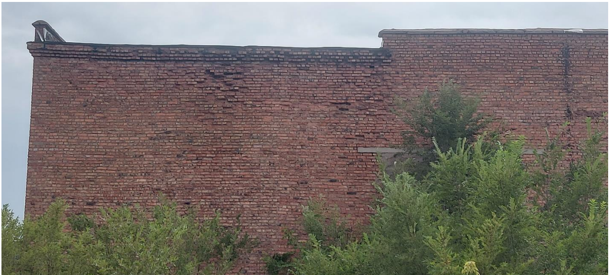
Пластинчатая деструкция кирпичных камней
